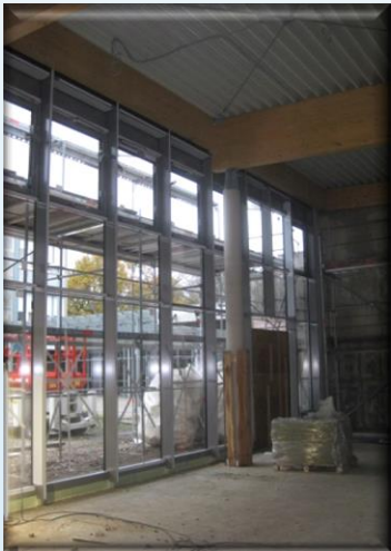
Blick aus dem Mensa-Neubau Foto: K+G Architekten, 05.12.2016
