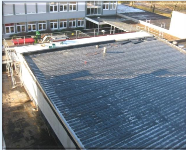
Blick auf den Mensa-Neubau Foto: K+G Architekten, 05.12.2016
