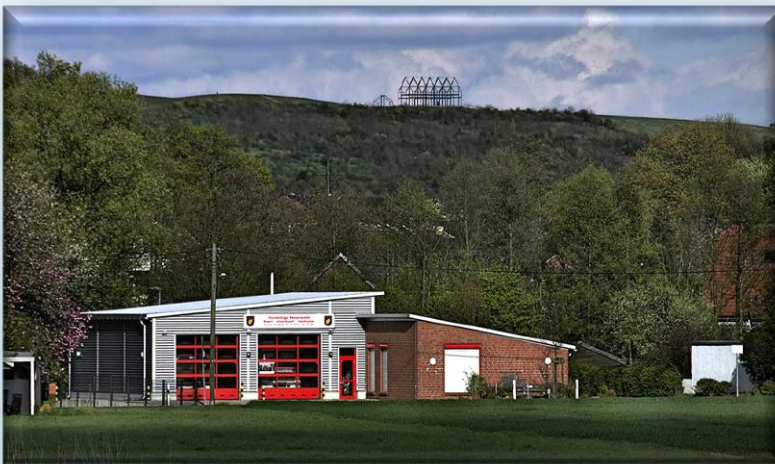
Gerätehaus Vluynner Straße 55
